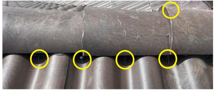
Figure 2.7.5 Sujetadores Expuestos (Exposed Fasteners)
