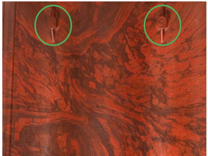
Figure 2.7.3 Localizadores de sujetadores (en frente)
